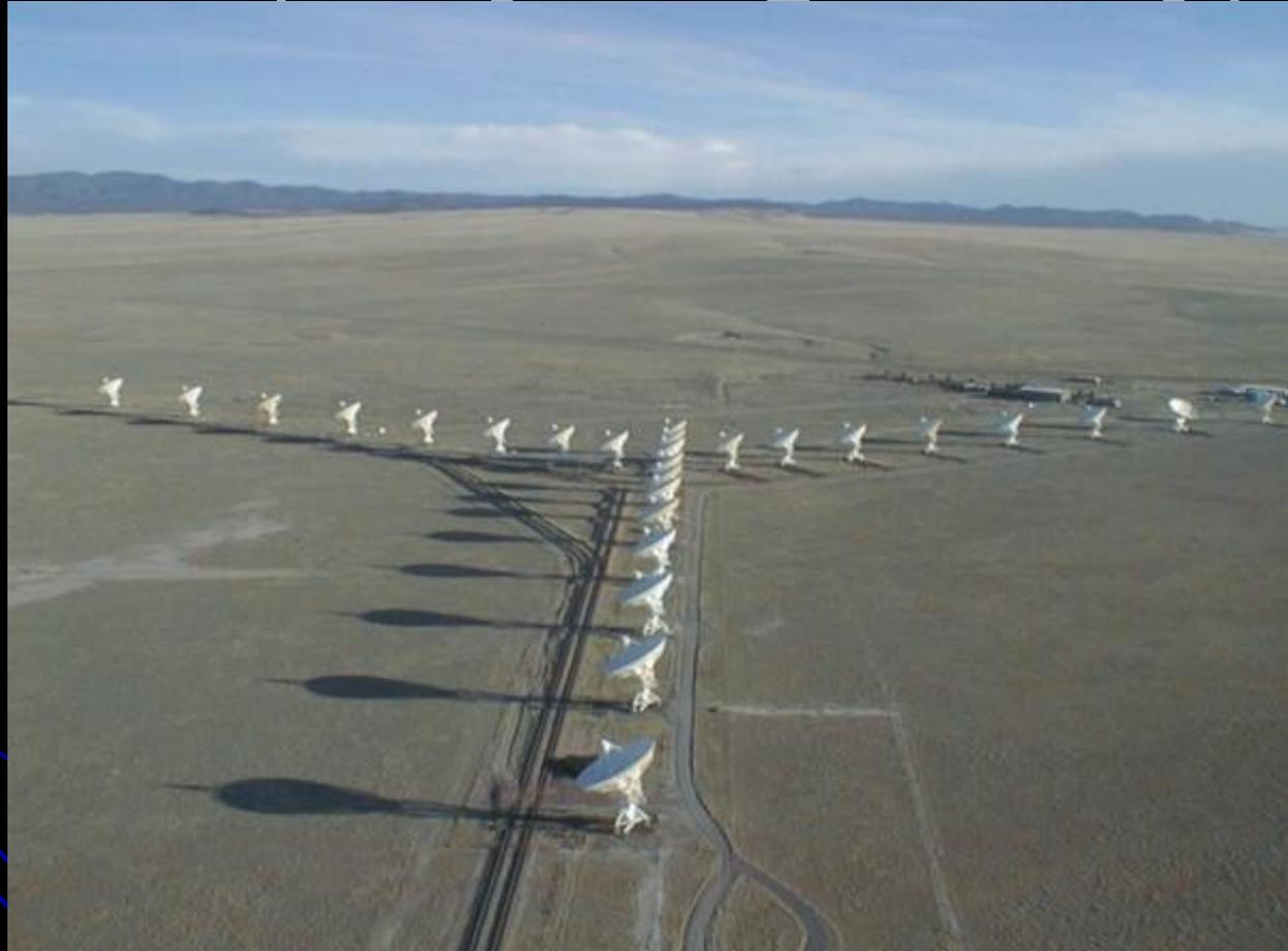
Conjunto de radio-telescópios instalados no Novo México, EUA. O conjunto opera de forma coordenada, observando a mesma fonte simultaneamente em todos. Isto permite obter imagens com altíssima resolução angular, numa técnica denominada interferometria.
