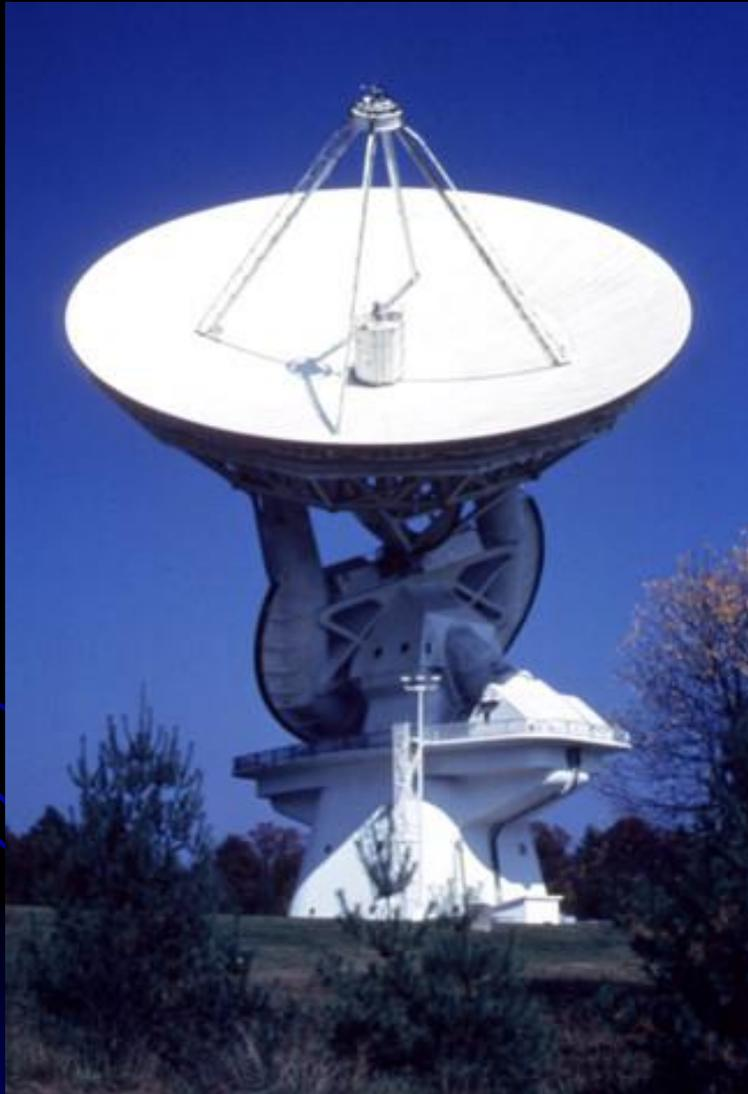
Radio-telescópio em montagem equatorial. O maior comprimento de onda da radiação requer áreas coletoras maiores.
