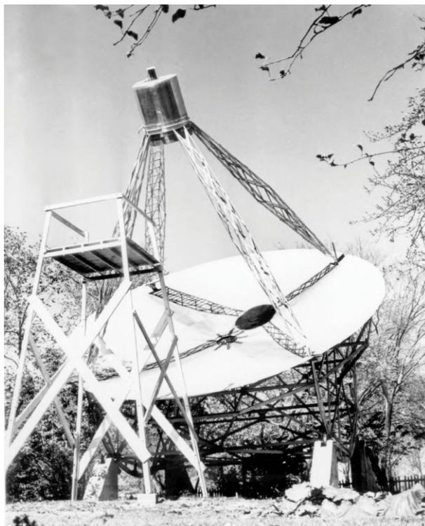
Figura 13 – Primeiro radiotelescópio construído por Grote Reber.
