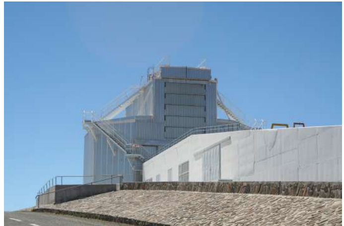
Figura 96 - O NTT (New Technology Telescope), localizado no Cerro de La Silla, foi o primeiro telescópio de grande porte a utilizar a técnica de óptica ativa. Seu design high-tech nem sequer lembra um telescópio tradicional. Foto: Francisco Conte.
