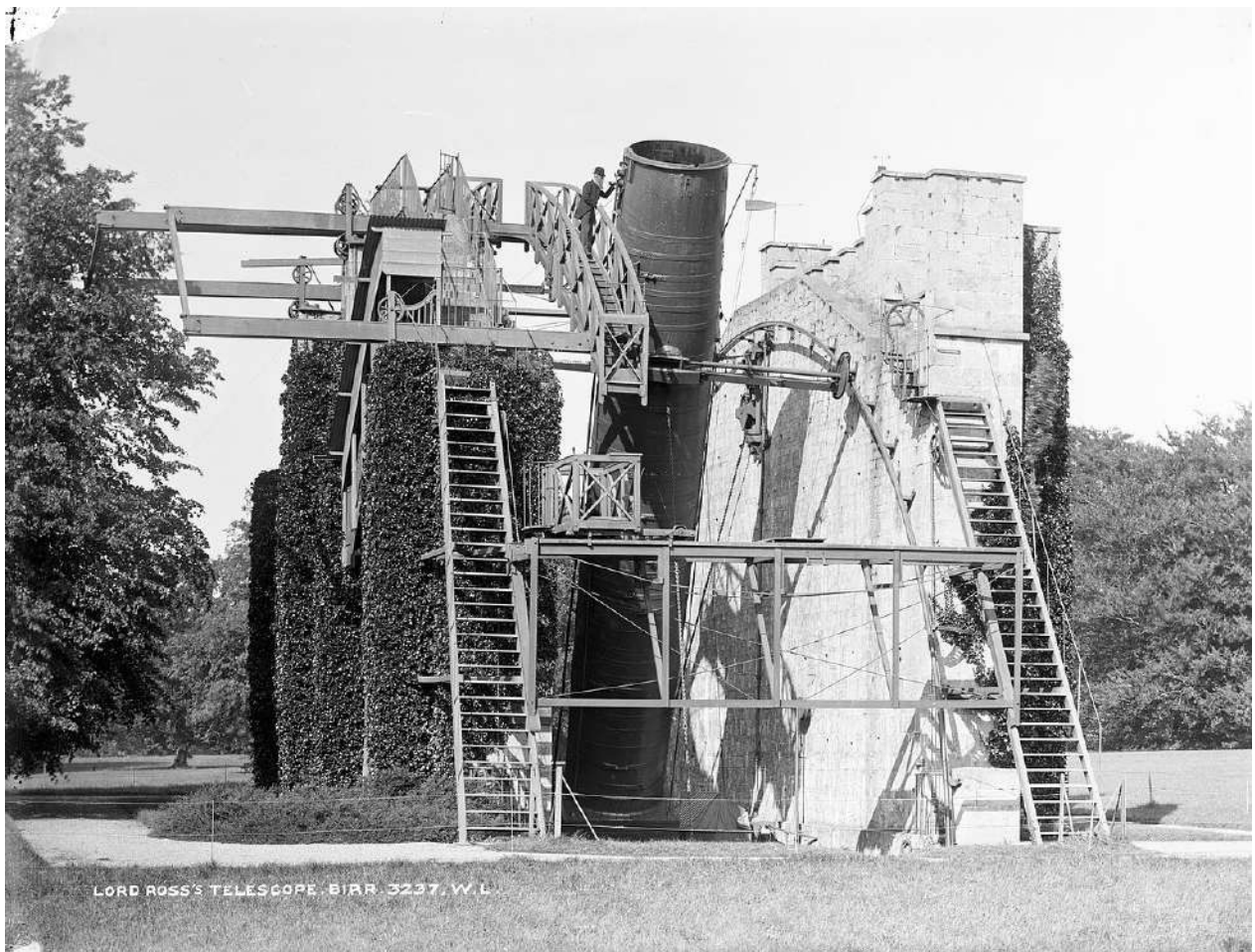
Figura 22 - O Leviatã de Parsonstown, construído pelo Lorde Rosse, o maior telescópio de seu tempo. Foi neste instrumento que pela primeira vez se observaram as estruturas de braços em espiral de galáxias. Fonte: Wikimedia Commons.
